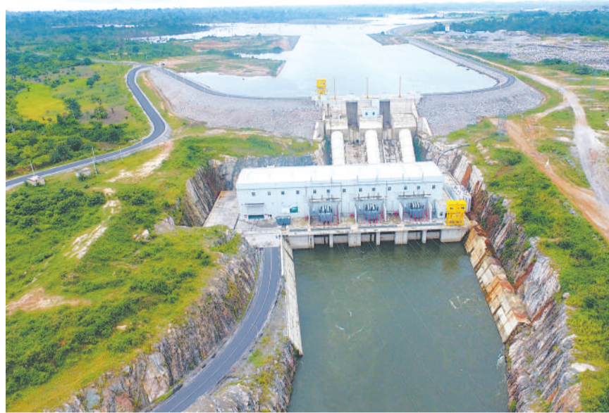
The Soubre hydroelectric power station in Côte d'Ivoire. (PHOTO: XINHUA)
